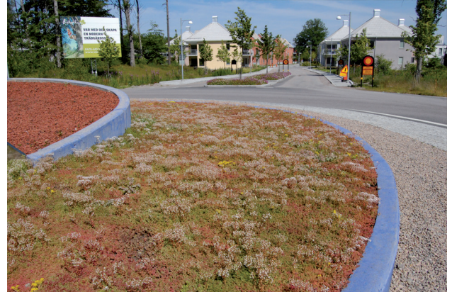
Sedummatte i Rundkørsel i Växjö, Sverige
