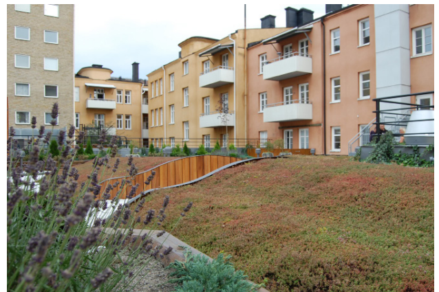
Sedum på tag i Norrköping, Sverige
