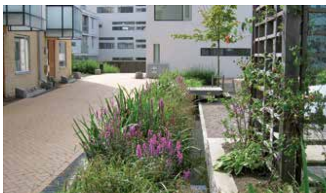
Selv mindre vandanlæg kan spille en væsentlig rolle i LAR-systemer i tæt bebyggelse.
